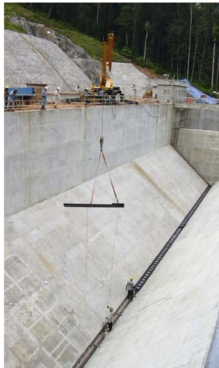
Construction d'un dessableur ouvert
