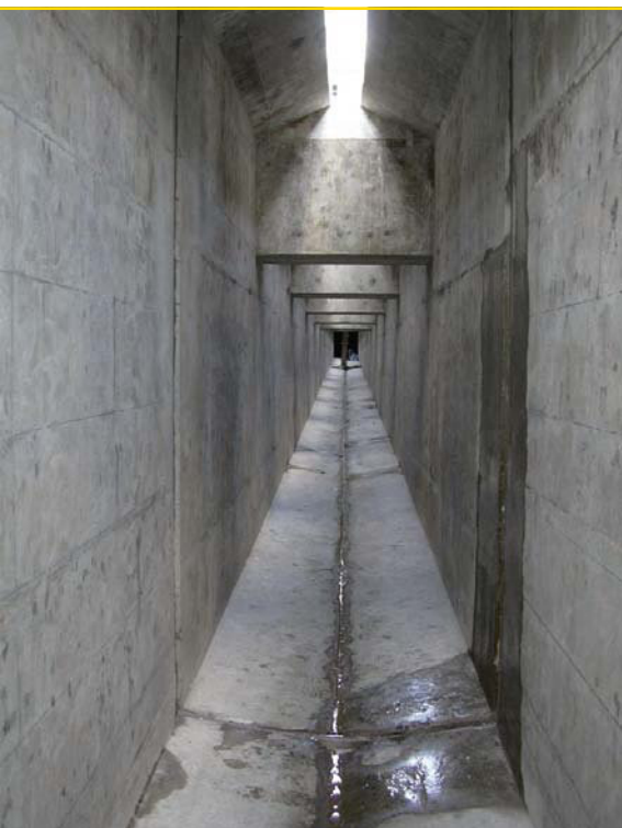
Coup d'œil sur le canal de purge
