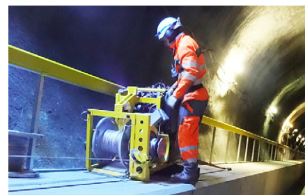
En haut: déroulement et freinage du câble de 400kV – En bas: Treuil à cabestan KZW 20 dans le tunnel du funiculaire
