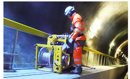
Oben: Abrollen und Bremsen des 400-kV-Kabels Unten: Kabelzugwinde KZW 20 im Stollen der Standseilbahn
