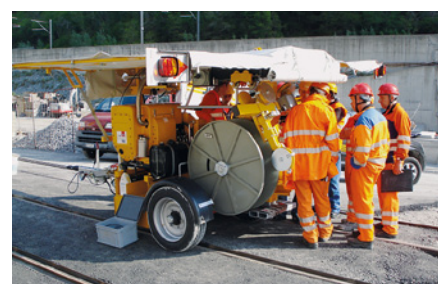
Formation du personnel de conduite pour davantage de sécurité
