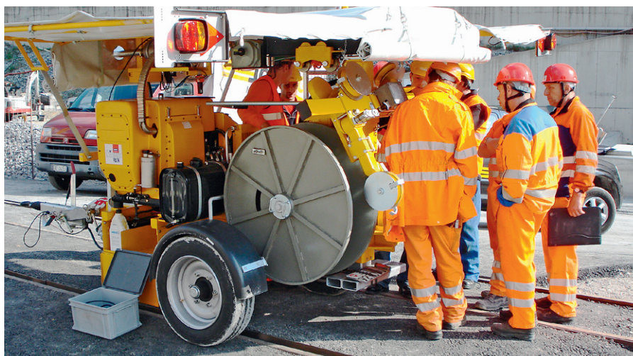
Das Bedienpersonal des Kunden wird an einer ausgelieferten Kabelzugmaschine KZM 4 geschult
